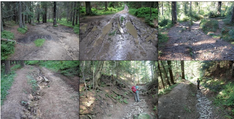
Ryc. 1. Przykłady degradacji szlaków turystycznych: (A) depozycja materiału na skutek niewłaściwego odwodnienia; (B) odcinek podmokły; (C) odsłonięte korzenie i skały na zbyt wąskim szlaku zmuszają odwiedzających do rozdeptywania pobocza; (D) bruzda erozyjna; (E) głębokie rozcięcie erozyjne sięgające podłoża skalnego; (F) Rozcięcie erozyjne - ze względu na trudne warunki przejścia, odwiedzający utworzyli nieformalną ścieżkę obok wyznaczonego szlaku.
