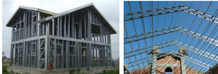
Rys.1. Zastosowanie prętów zimno formowanych w konstrukcji budynków
